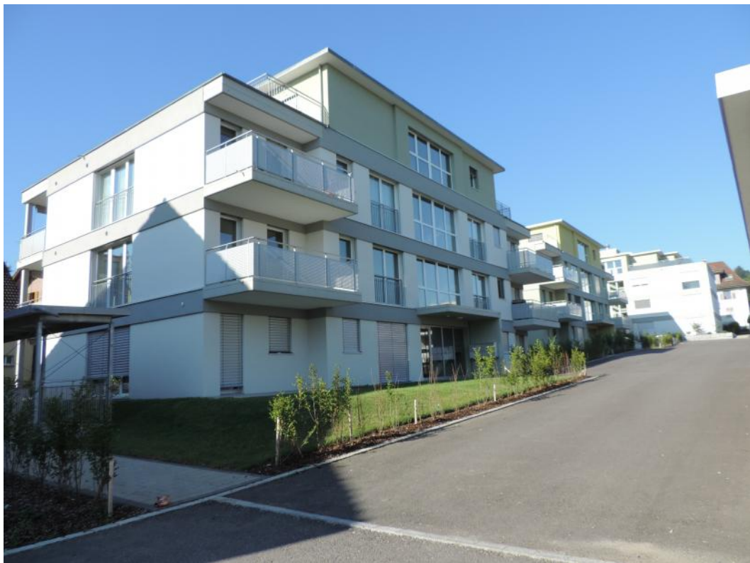
Überbauung Bachperle (8 MFH) Muri AG innere und äussere Malerarbeiten Architekt: Beeler Bauplaner AG Dorfplatz 8917 Oberlunkhofen
